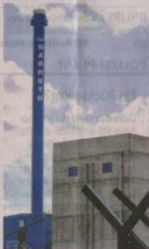
Die Verbrennungsanlage läuft nun im Regelbetrieb. Foto: Buchholz
