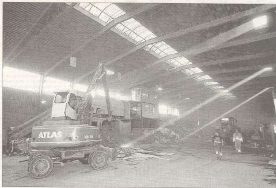
Zu den Geschäftsbereichen der Harmuth Entsorgung GmbH gehört die gesamte Palette der Entsorgungsdienstleistungen.
